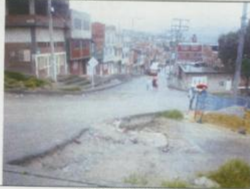
Tramo sin iniciar
